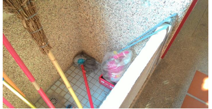
說明：滅火器放置盒放置後。
