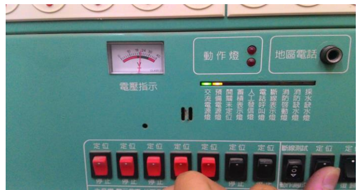
說明：預備電源修繕後
