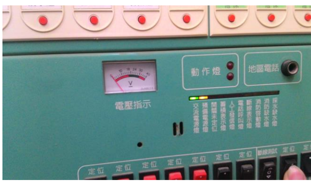
說明：預備電源修繕前
