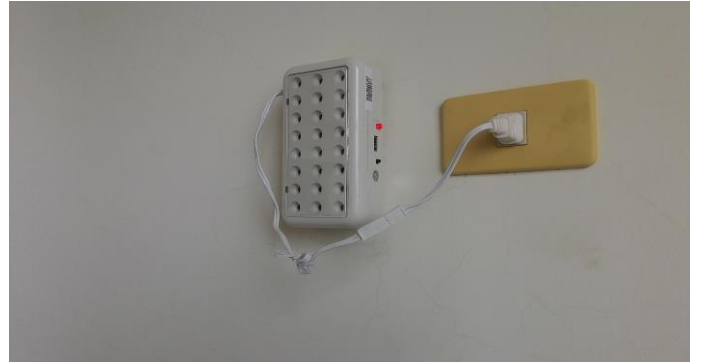
說明：照明燈故障處理後。
