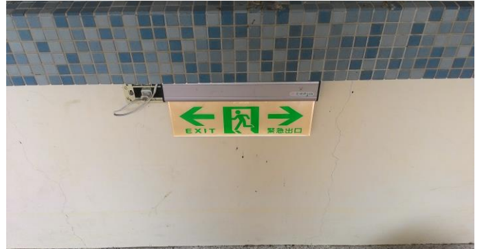
說明：避難方向指示燈修繕後。
