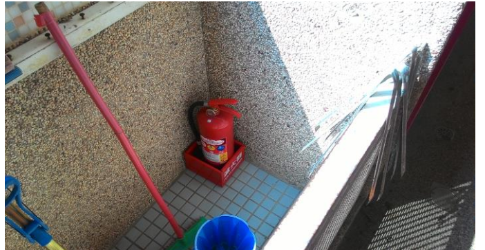
說明：滅火器放置盒放置後。
