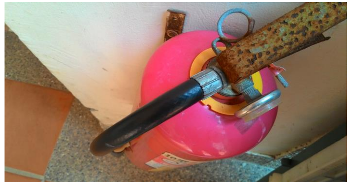
說明：滅火器皮管鏽蝕處理後。
