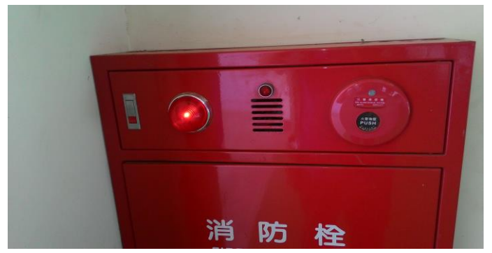
說明：火警標示燈修繕後。
