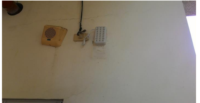
說明：照明燈故障處理後。
