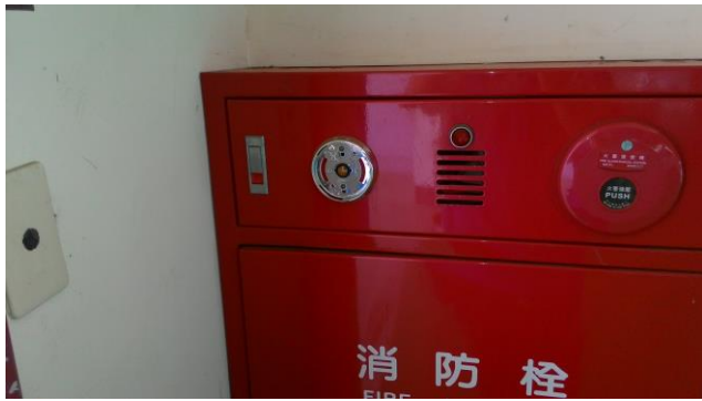
說明：火警標示燈修繕前。
