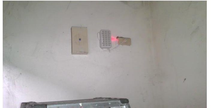
說明：照明燈故障處理後。
