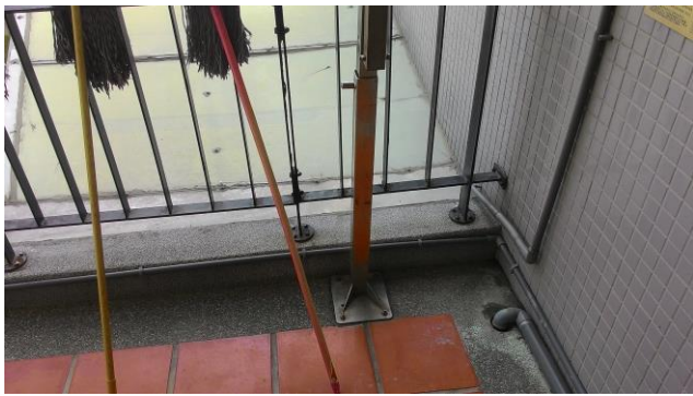
說明：緩降機支架位移前。
